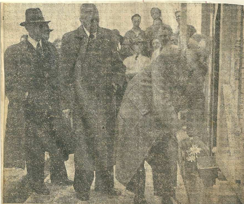
Valkenburg krijgt 27 nieuwe woningen aan de Marinus-Poststraat. Wethouder N. Ouwersloot heeft gisteren de eerste steen gelegd. (Foto: N. v. d. H.)
