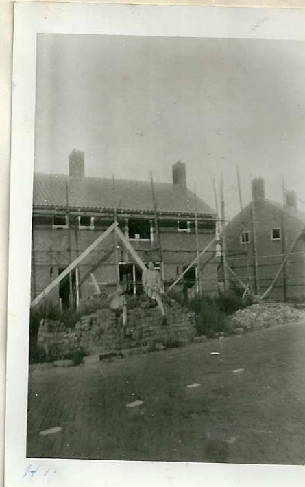
Huizen in Mol. Poststraat in aanbouw. Oct. 1950
